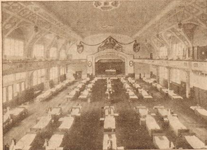
München: Die größte und schönste Turnhalle Deutschlands (des Männerturnvereins von 1879) wurde in ein Lazarett mit 170 Betten nebst Operationssälen und Verbandsräumen umgewandelt.
