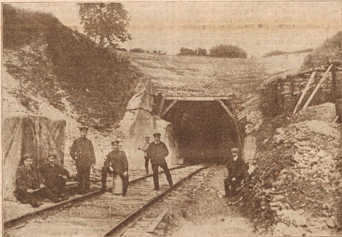
Ein belgischer Eisenbahntunnel, der von den Belgiern zur Behinderung der deutschen Bahntransporte zerstört und von den Deutschen binnen kurzer Zeit wiederhergestellt wurde.
