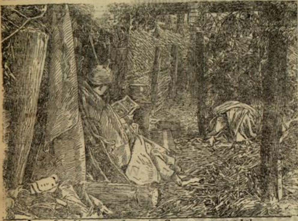
Schlitzgraben im Argonnerwald
