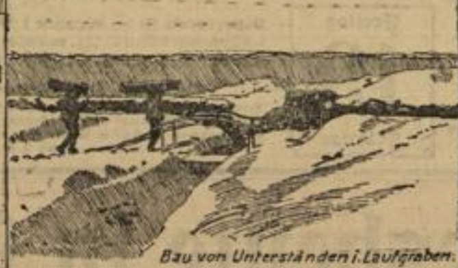
Bau von Unterständen i. Laufgraben.
