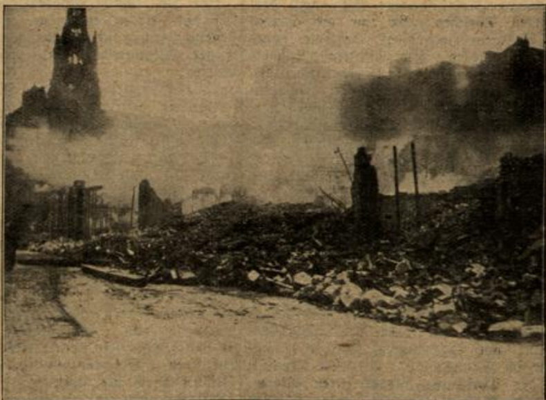
Aus dem eroberten Lille: Durch die Beschießung zerstörte Straße.
