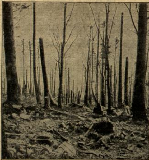
Zerschossene Waldhohebene auf dem Hartmannsweilerkopf.
