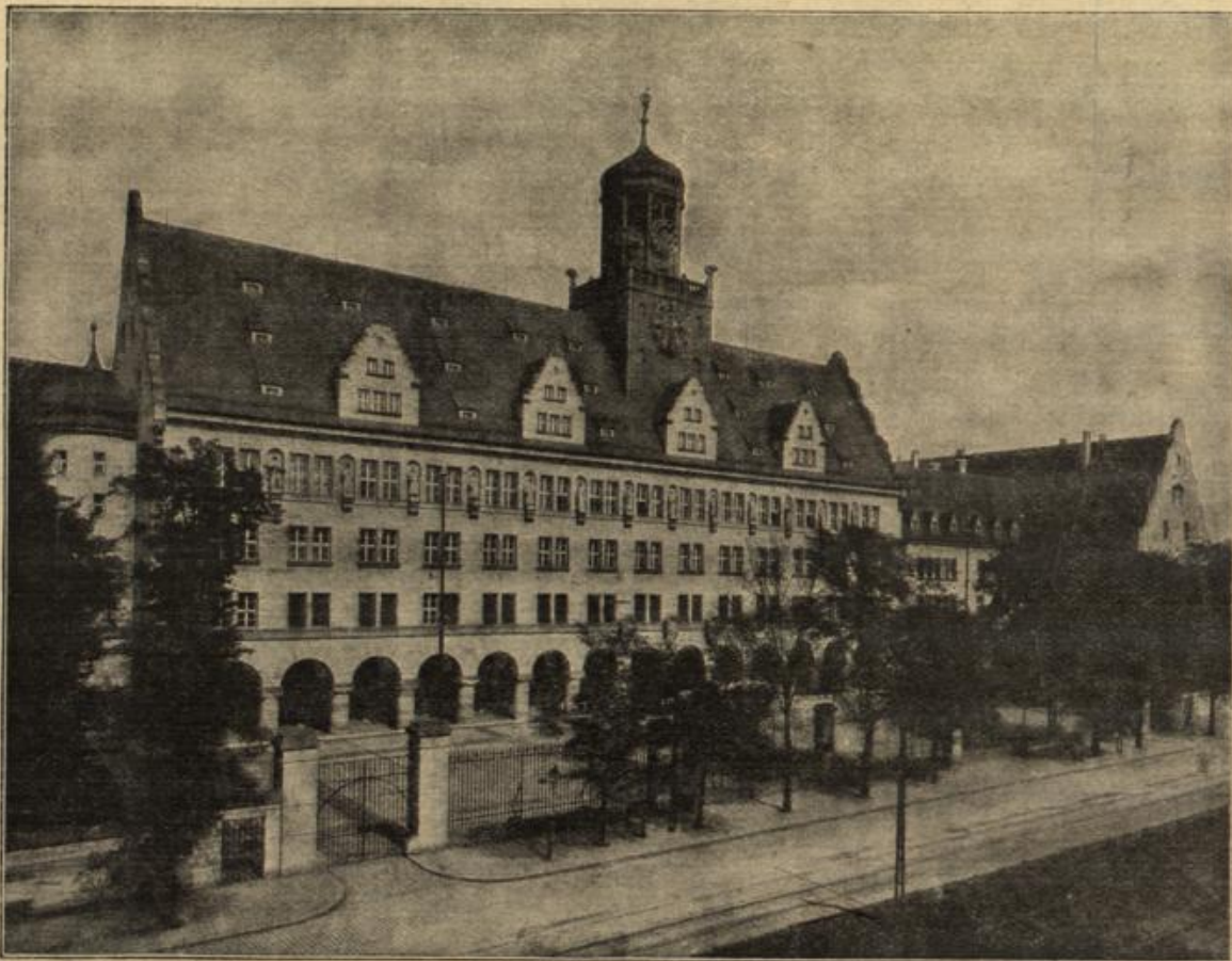
Das neue Zentraljustizgebäude in Nürnberg. (Mit Text.)
