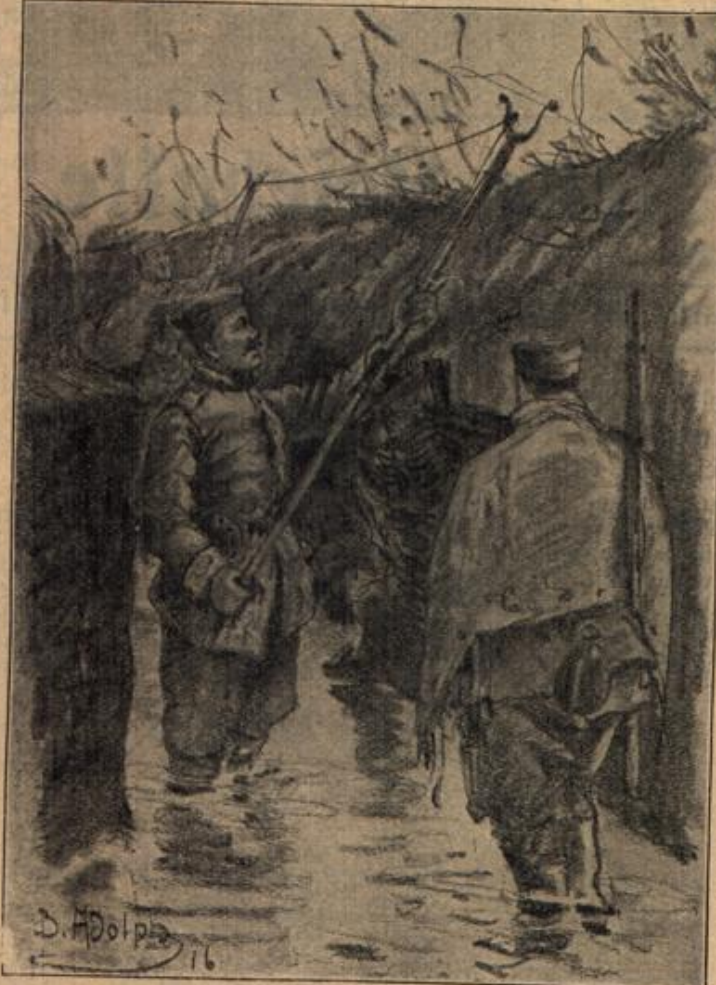
Er schwerte Arbeiten unserer Feldgrauen in einem durch Regen beschädigten Zulaufgraben.
