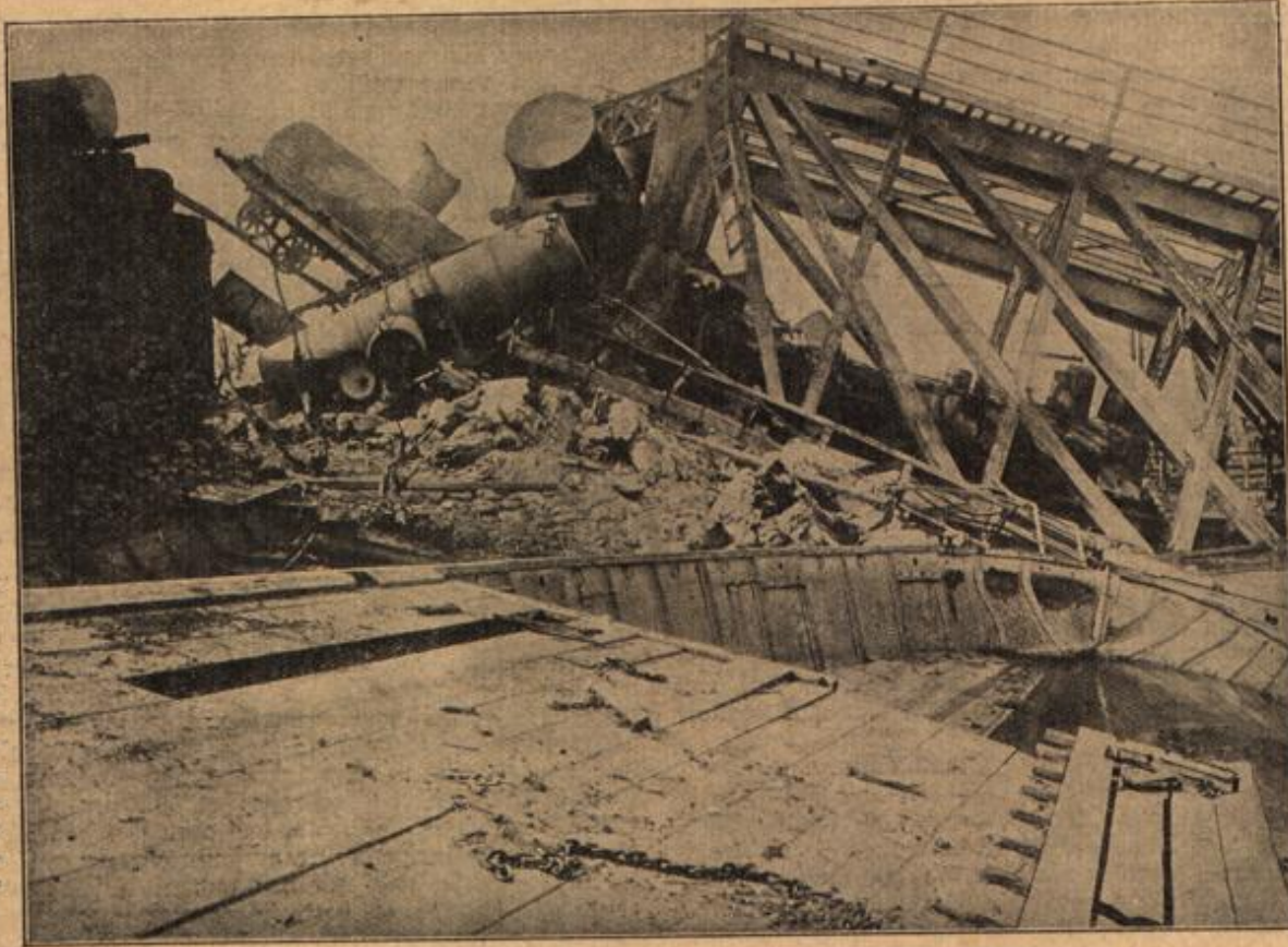
Aus der eroberten Festung Grodno: Eine zerstörte Eisenbahnbrücke mit einem abgestürzten Zug. Im Vordergrund ein Remeschiff, das in das Chaos hineingetrieben wurde.
