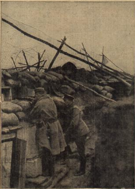
Ein mit Sandsäcken und Drahtnetzen gegen Bomben gesicherter deutscher Schützengraben bei Reims.
