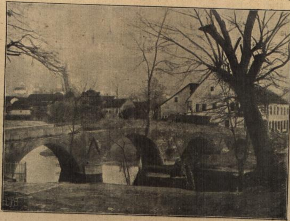
Der Ort Ujice in Serbien, der von den Bulgaren erobert wurde. Im Vordergrund die alte Türkenbrücke.
