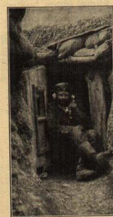
Telephonstille im bombensicheren Unterstand.
