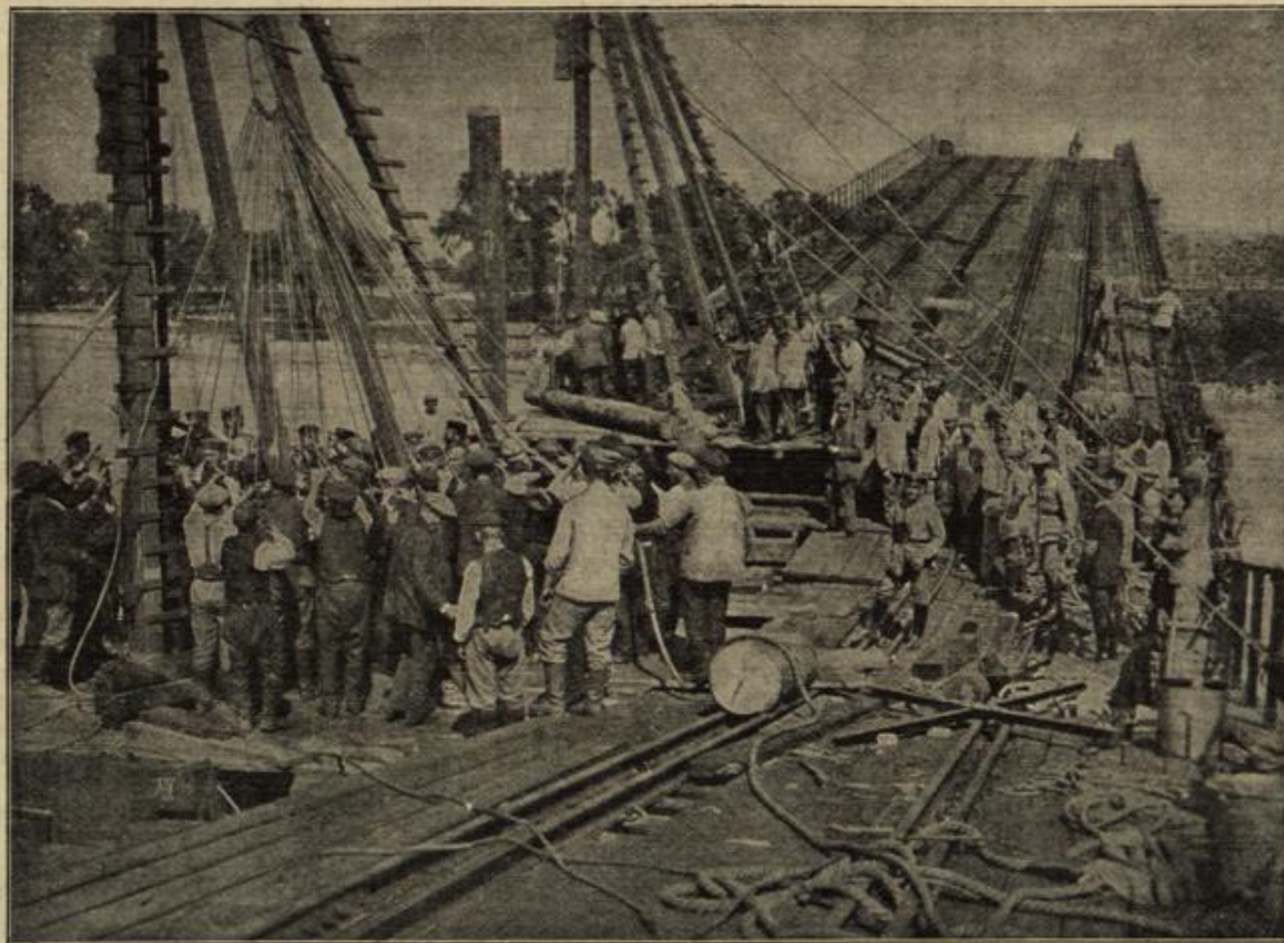
Deutsche Pioniere bei der Instandsetzung der von den Russen gesprengten Weichselbrücken in Warschau. (Mit Text.) Phot. R. Sennede.
