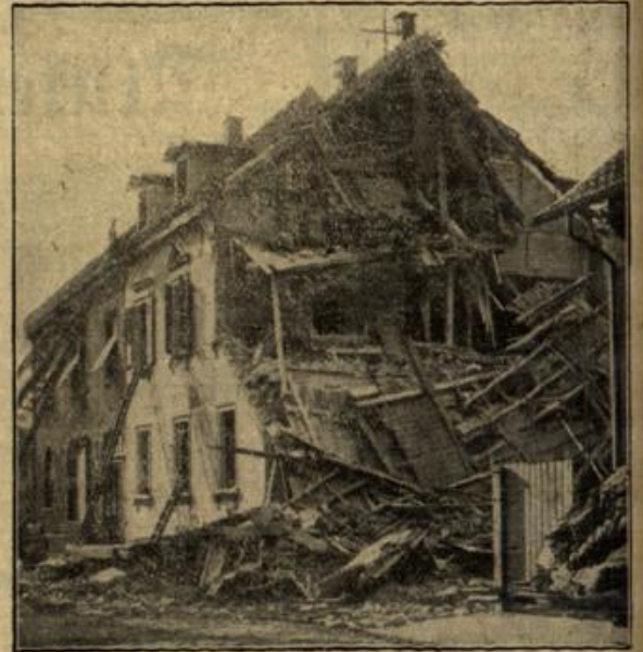
Infolge Bombenangriffs zerstörtes Haus in Ludwigshafen.
