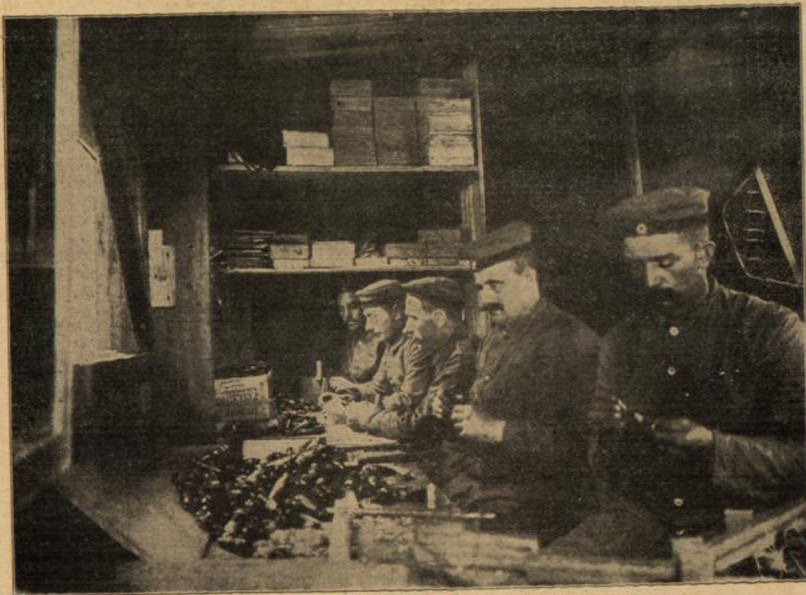
Munitionsfabrikation an der Westfront: Bei der Herstellung von Zündern.
