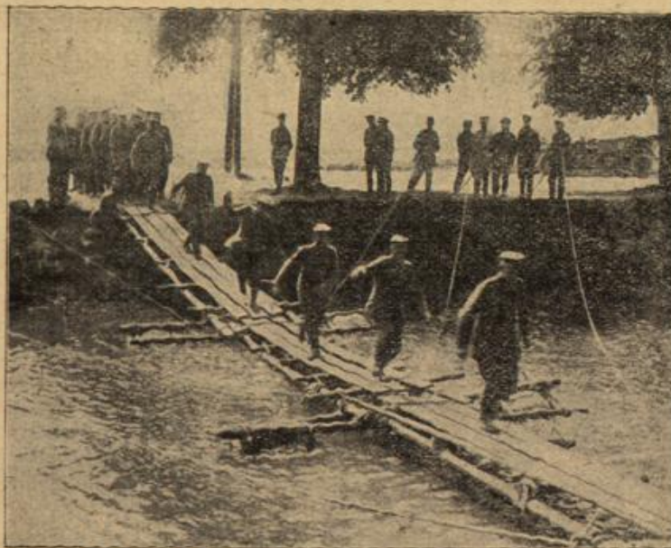
Passieren einer in kürzester Frist hergestellten Schnellbrücke im Dampfgebiete des Westens. Berliner Ill.-Gesellschaft m. b. H.
