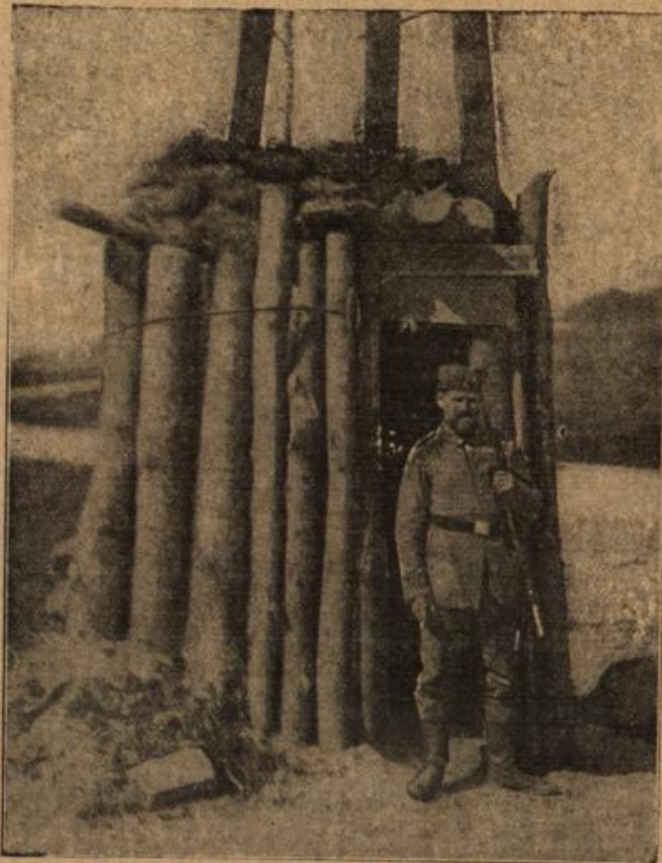
Ein deutsches „bombensicheres“ Schilderhaus im Osten. Das Dach des originellen Schilderhauses ist mit Erde, auf der das Gras üppig wächst, bedeckt. Das Ganze beweist, wie sinnreich unsere Feldgrauen zu Werke gehen.
