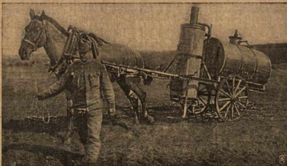
Fahrbarer österreichisch-ungarischer Desinfektionsapparat für Kleidung und Wäsche.
