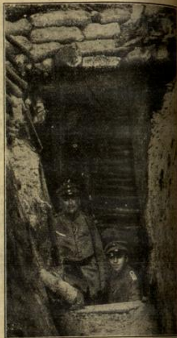
Ein fünf Meter tiefer sog. Granatsollen, Schutz gegen alle einschlagenden Geschosse bietend. (Phot.: D. Zeitung.)
