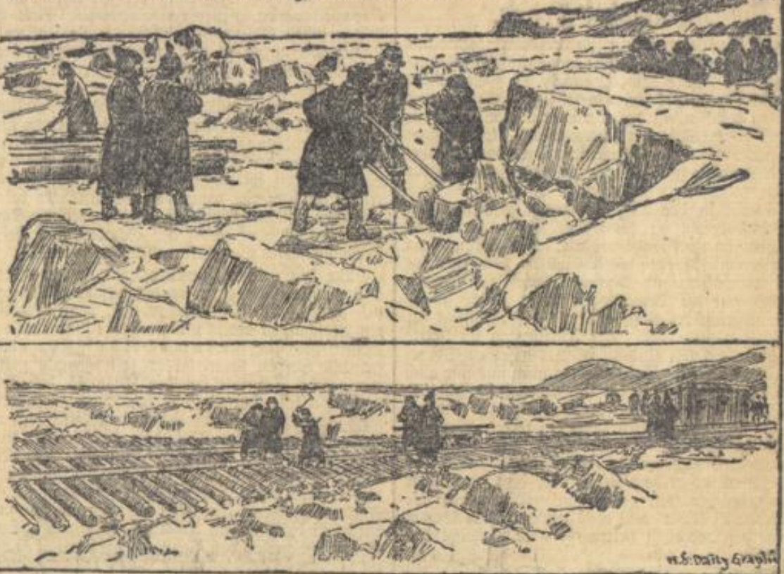
Der Eisenbahnbau über den zugefrorenen Baikalsee.
