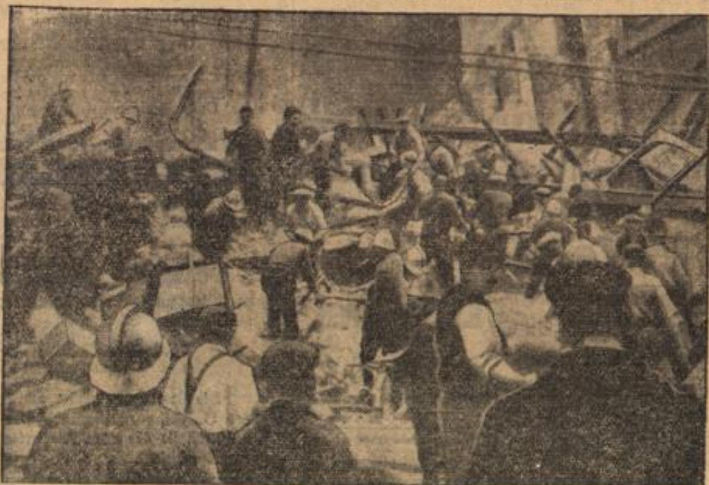
Funkbild von den ersten Aufräumarbeiten.
