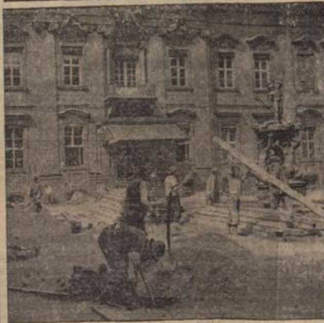
Der Umbau des Reichspräsidenten-Palais hat begonnen.
