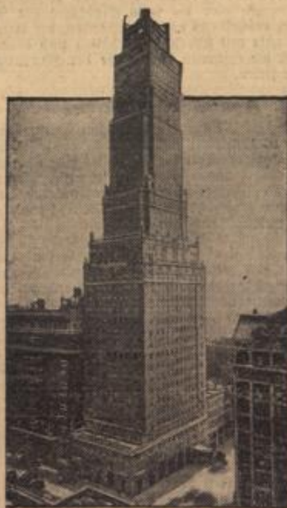
Schwere Explosion in einem New Yorker Wolkenkratzerhotel.
