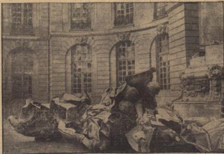
Das zerstörte Bretonne-Denkmal in Rennes.
