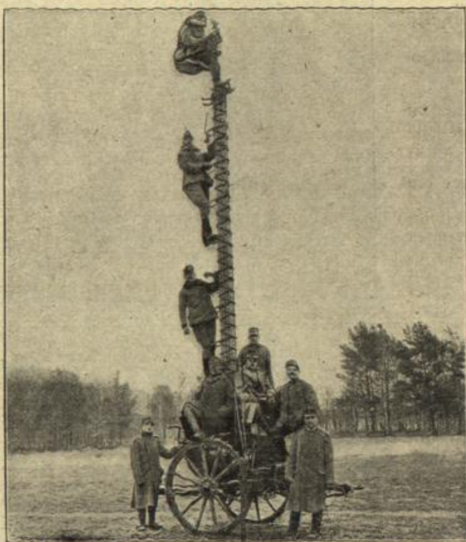
Fahrbare und zusammenlegbare österreichisch-ungarische Beobachtungsstelle mit Telephon. Photopresse Kankowsky, Budapest.
