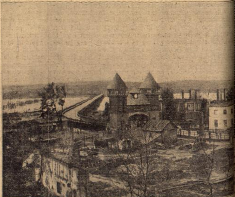
Die neue Reichelbrücke bei Putawy; ein Werk österr.-ungar. Kulturarbeit in
