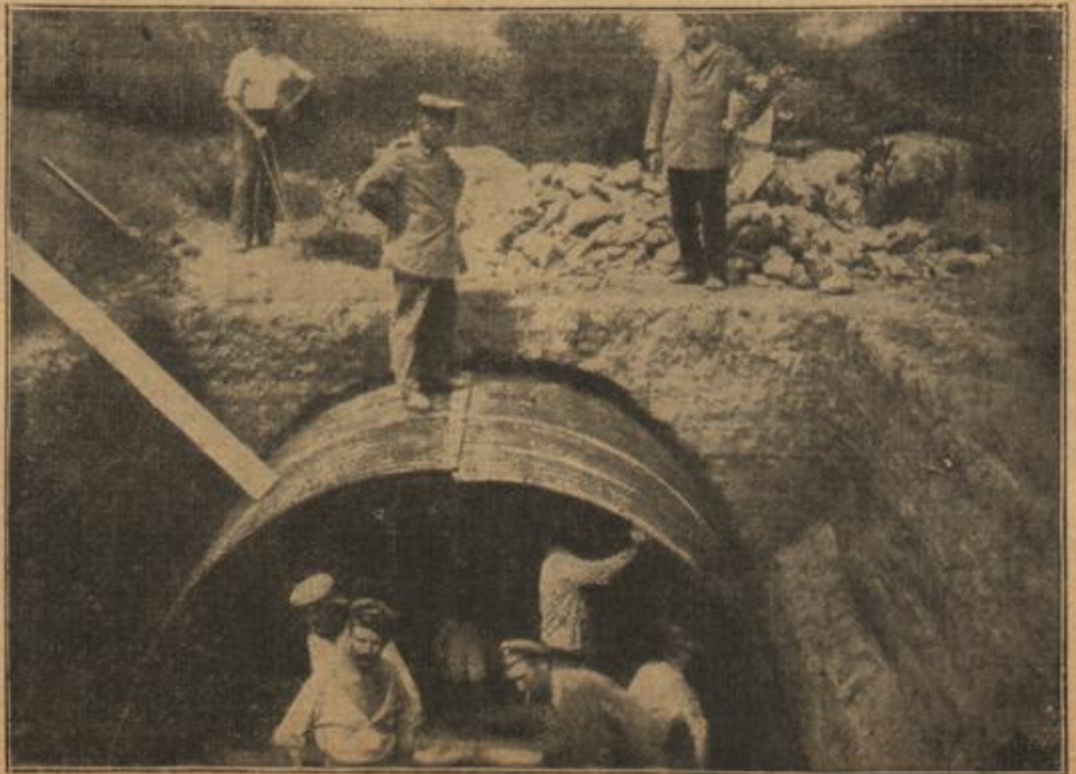
Bau eines bombensicheren Unterstandes in Mazedonien.
