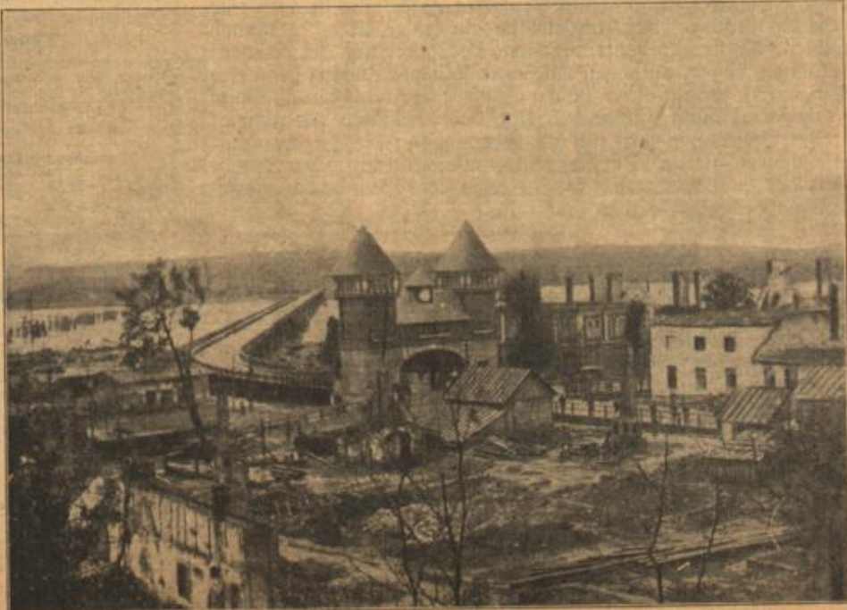
Die neue Weichselbrücke bei Pultawy; ein Werk österr.-ungar. Kulturarbeit in Polen.
