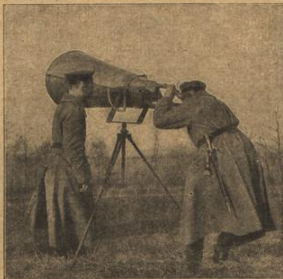
Horchapparat, mit dem die Annäherungsrichtung feindlicher Flugzeuge festgestellt wird.
