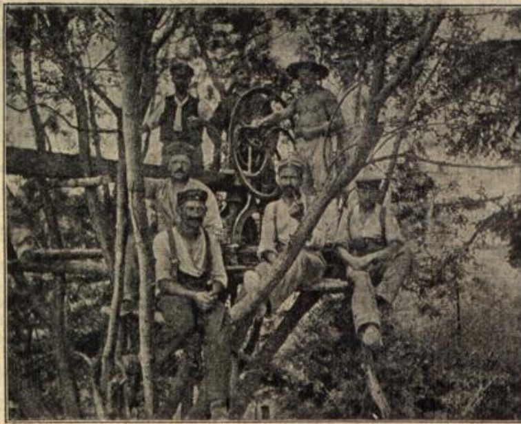
Pumpvorrichtung zum Entwässern und Trodenhalten von Schützengräben.
