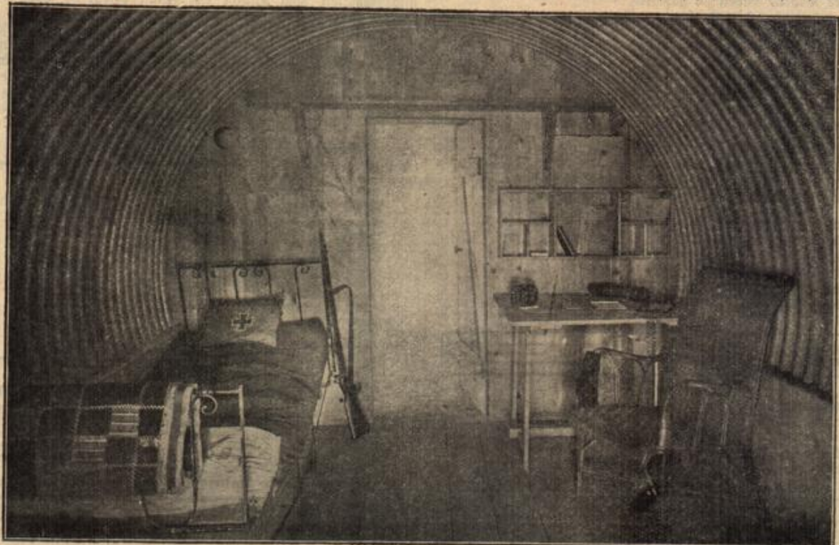
Inneres eines Beton- und Wellblechunterstands auf dem westlichen Kriegsschauplatz. Phot. Max Wipperling.
