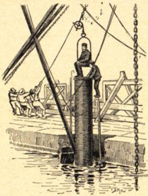
Ein in Schweden erfundener Bergungsapparat. Einfahrt in die Röhre.
