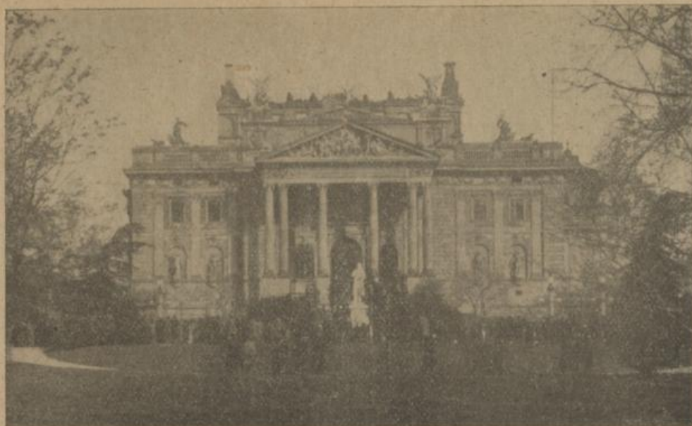
Staatstheater in Wiesbaden: Bühnenhaus nach dem Brände.
