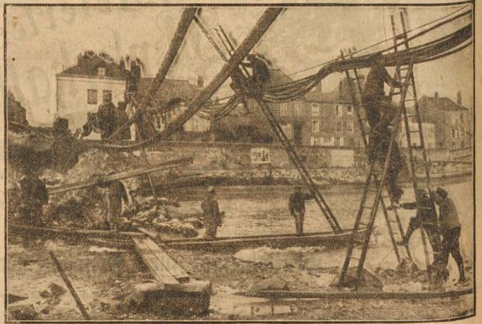
Eine Feldtelegraphen-Abteilung beim Legen von Kabeln.
