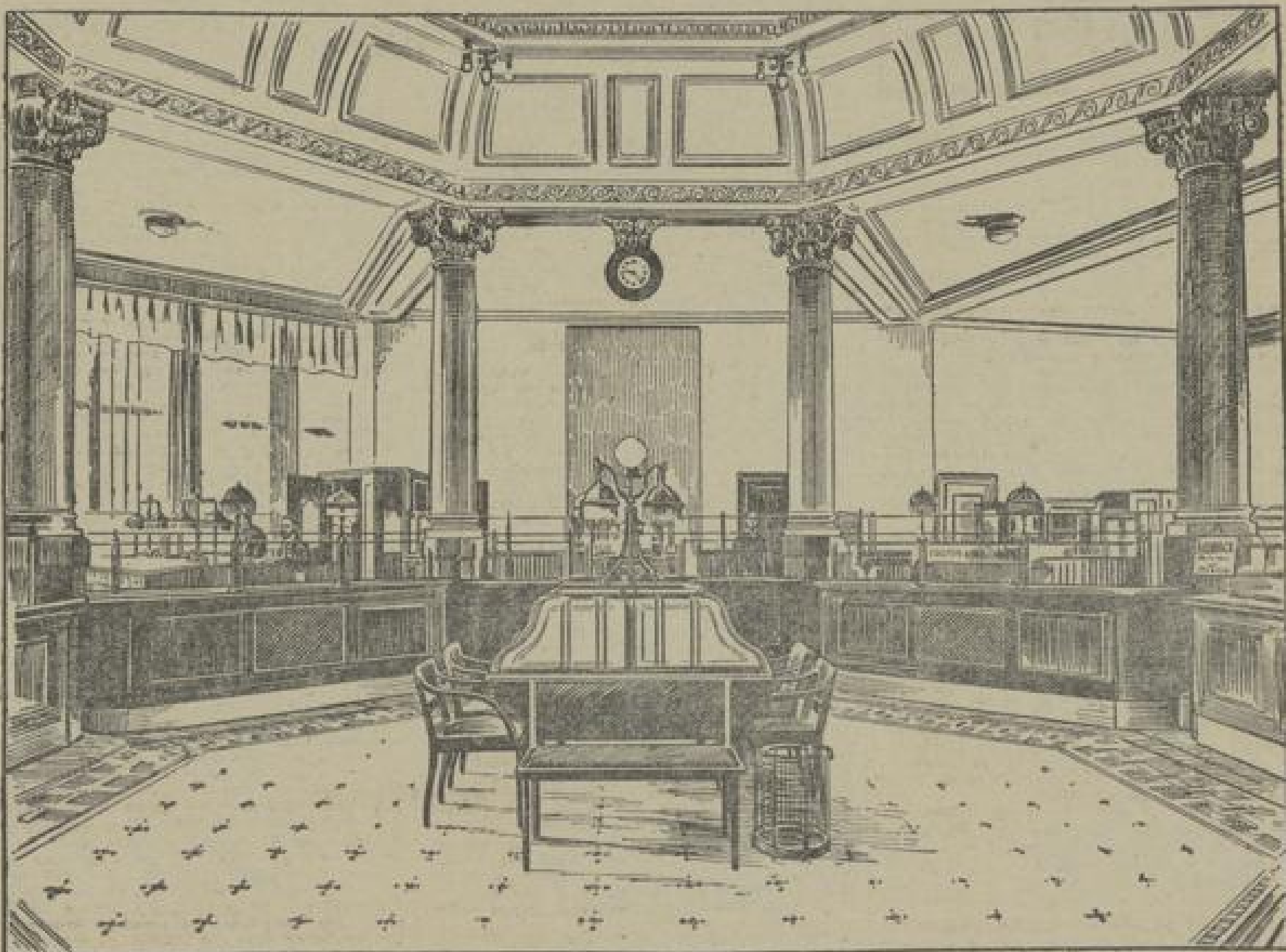
Der Kassenraum des Bankhauses Spener-Cliffen.
