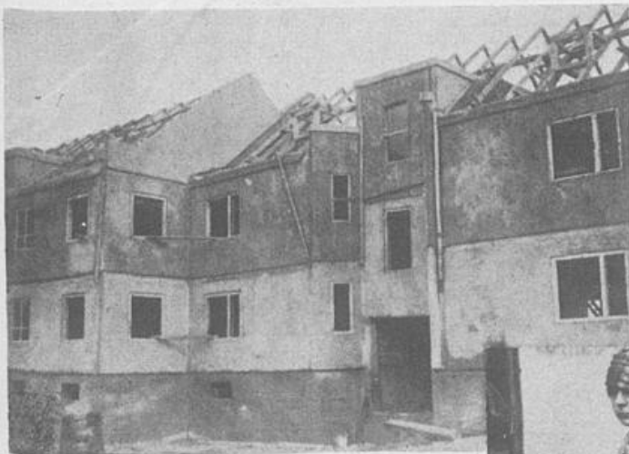
Häuser, die an einem Tage erstehen Praktische Versuche mit einem neuen Schnellbauverfahren in Berlin. Im Rohbau fertiggestellte Wohnungen. [Atlantic]
