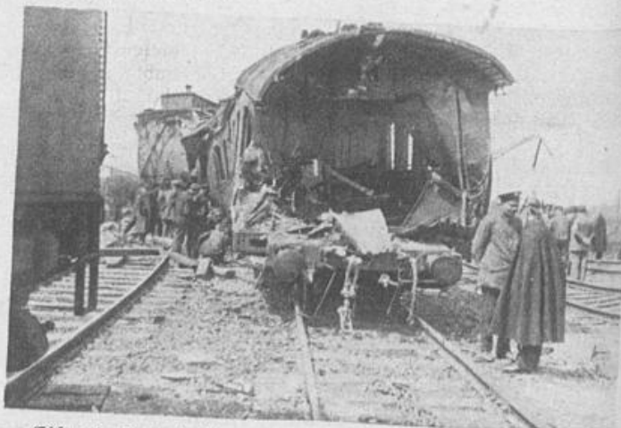
Eisenbahnkatastrophe im Münchener Ostbahnhof An der Trümmerstätte am Morgen nach dem Pfingstmontag. [Kester & Co.]
