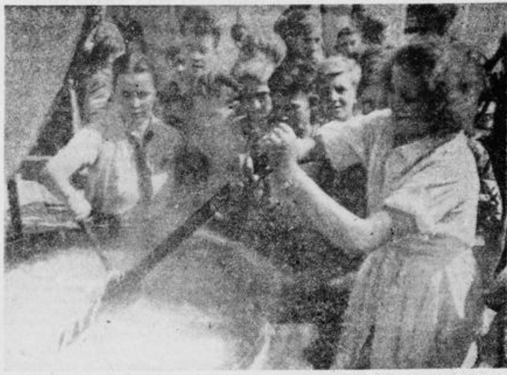
HJ. beim Bau von Schutzstellungen NS-Frauensschaft und BDM. sorgen überall für ein kräftiges Feldküchenessen
