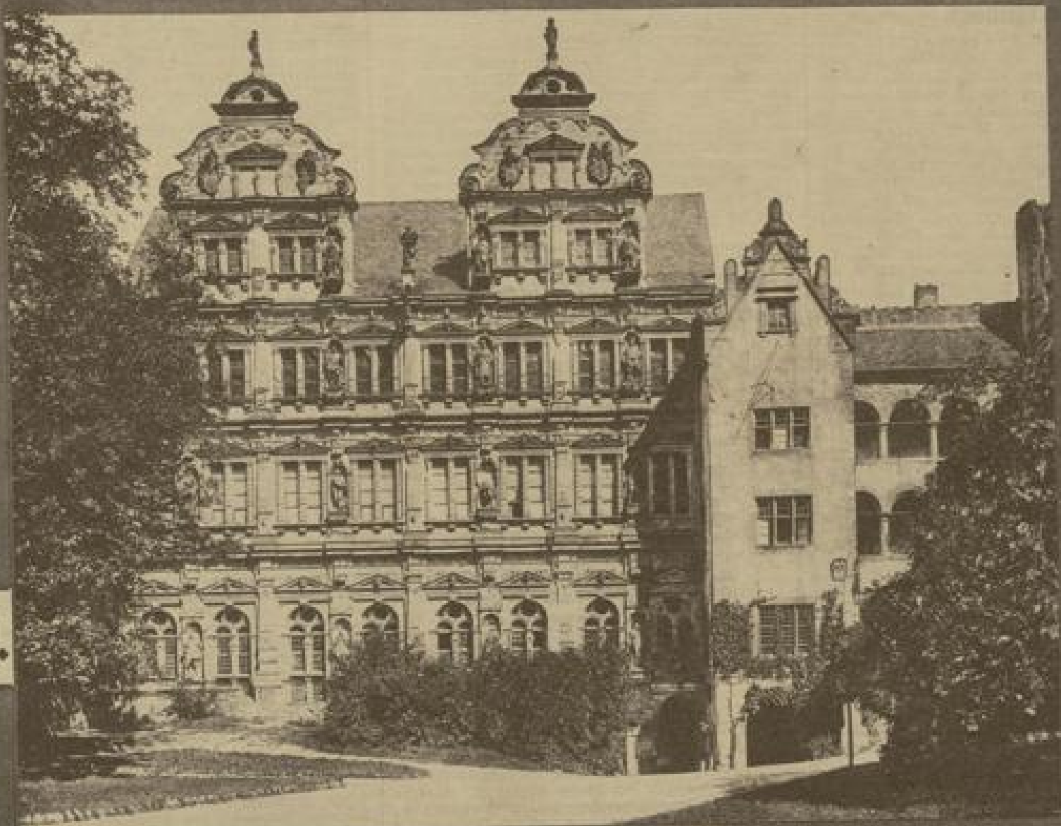
Heidelberger Schloß; Der Friedrichsbau.
